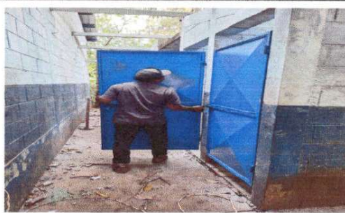
Foto 6: Fabricación e instalación de puertas de metal en baños.
