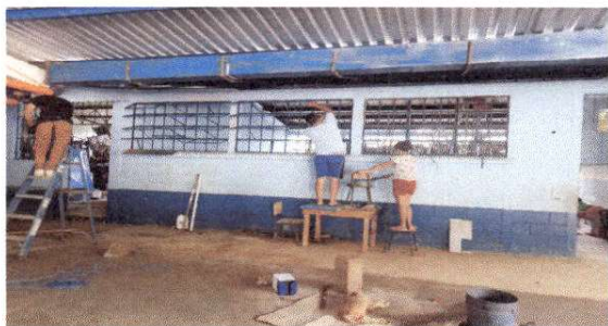
Foto 9: Pintura en muros exteriores
