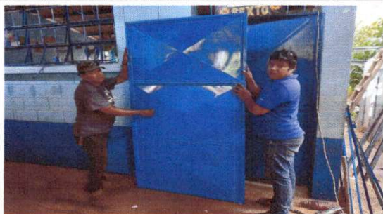
Foto 5: Fabricación e instalación de puertas de metal en módulos
