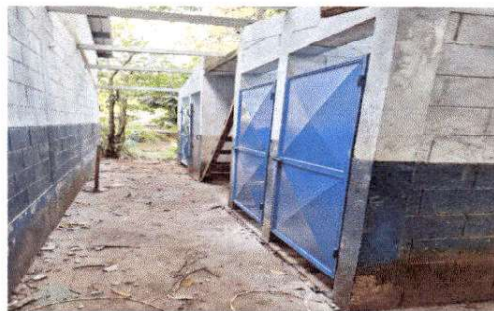
Foto 8: Sustitución de lámina, por lámina troquelada aluzinc calibre 26
