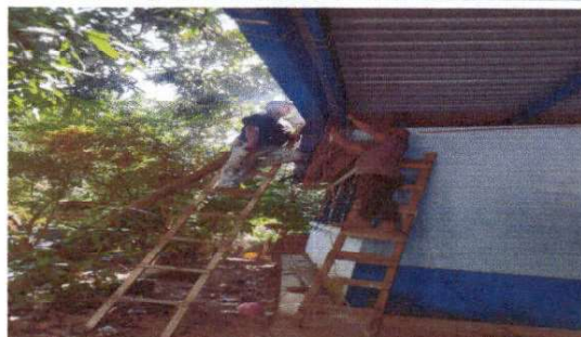
Foto 4: Sustitucion de canal PVC
