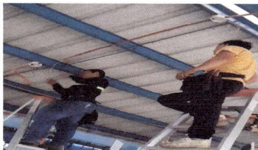
Foto 12: Sustitución de lamparas tipo LED, reparacion de cableado electrico
