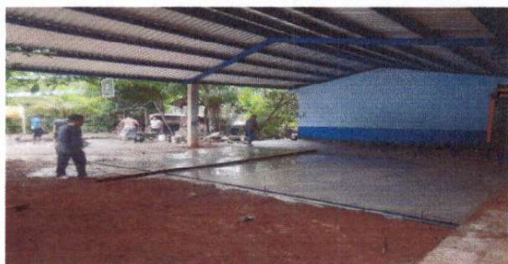
Foto 3: Reparación de piso torta
