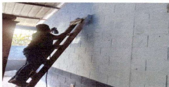
Foto 10: Pintura en muros interiores
