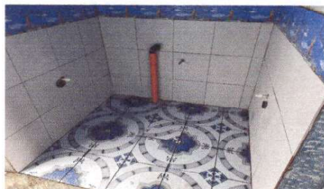
Foto 2: Sustitución de lavamanos.
