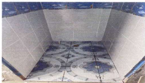
Foto1: Sustitución de inodoro
