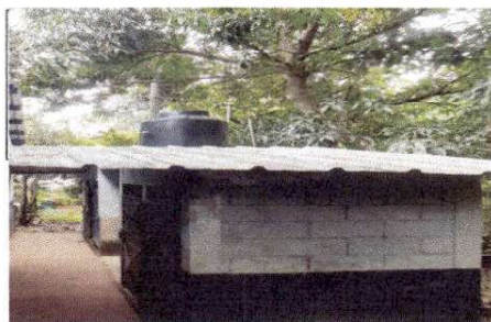
Foto 11: Sustitución de depósito de agua 2,500 lts
