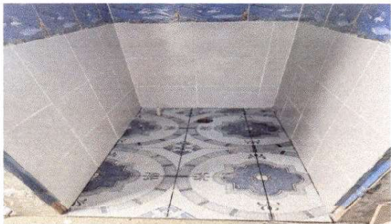
Foto 7: Sustitución de azulejo.
